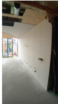
Voorbeeld van een wand in OSBplaat met gipskartonplaat waar er elektrische als sanitaire punten erin verwerkt zit.
