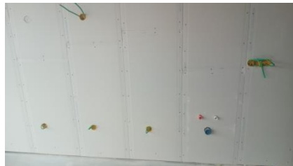
Voorbeeld van een wand in OSBplaat met gipskartonplaat waar er elektrische als sanitaire punten erin verwerkt zit.
