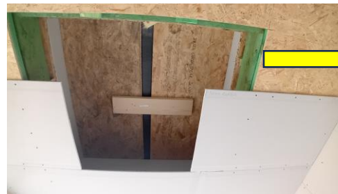
Het dakraam werd geplaatst, ze kunnen de afwerking binnen uitvoeren Het dakraam werd geplaatst, ze kunnen de afwerking binnen uitvoeren
