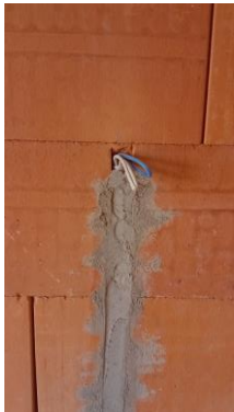
Deze muur zal worden gestuct.
