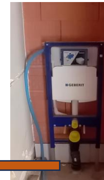
(3) Aftakpunt van de algemene DWA leiding diameter 110 mm onder de fundering. Daarop zullen alle afvoerleidingen van sanitaire voorzieningen in de directe omgeving worden aangesloten. De diameters kunnen variëren naargelang de situatie.
